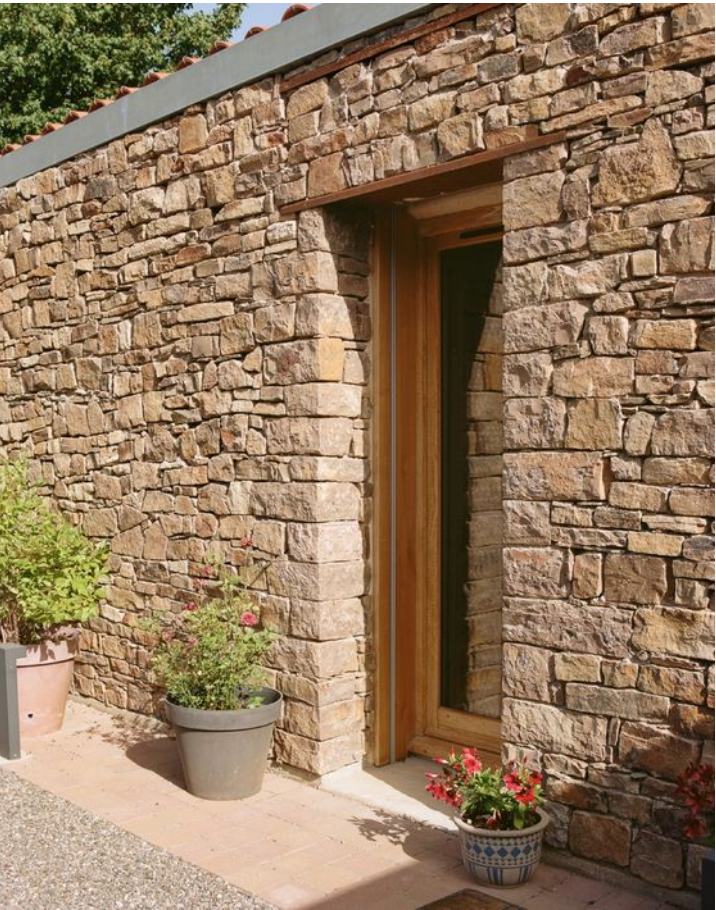
La maison du Garrissou (81) — une maison contemporaine en pierre de pays pour bien vieillir en centre-bourg. © Antoine Séguin
