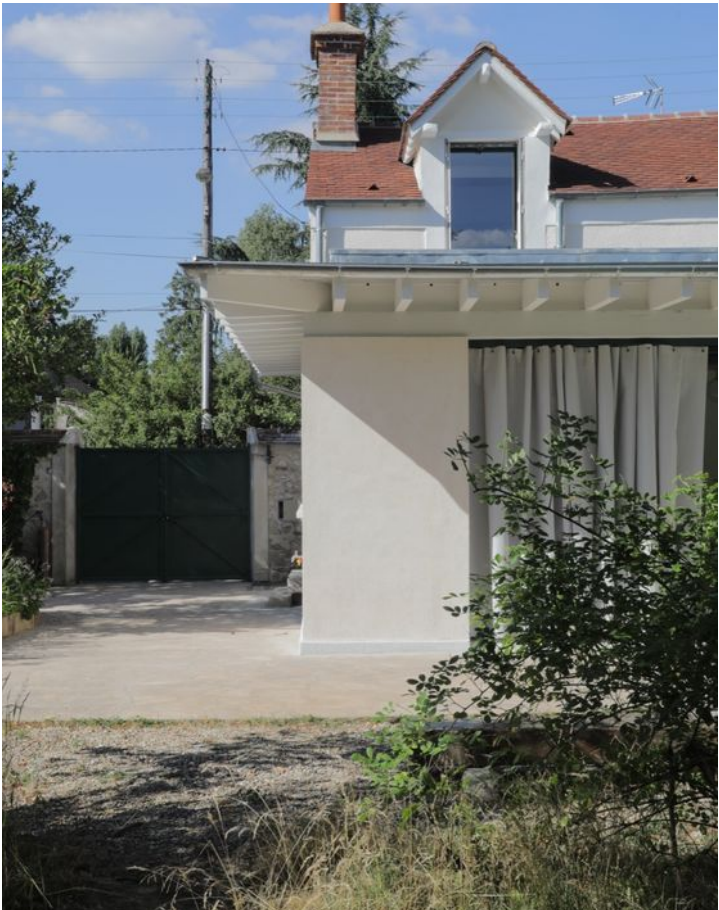
Rue Gringoche — rénovation complète et extension d'une maison bacotte. En collaboration avec Amor Immeuble. © Amor Immeuble
