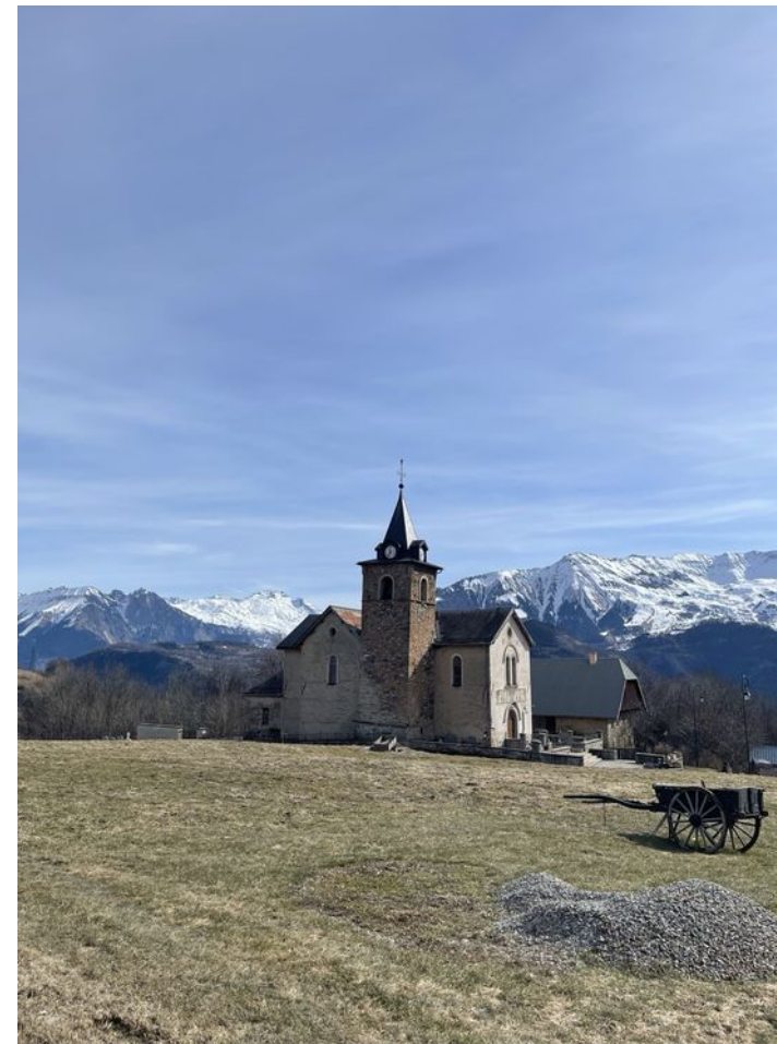
Église Saint-Pierre-aux-Liens de Villarembert (73) — vue générale, clocher médiéval. Restauration complète. © Caryatides Architecture
