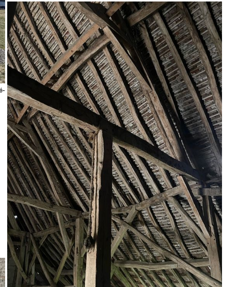
Grange aux Dîmes, La Bruyère — démontage, restauration et remontage sur le site de l'écomusée de l'Étang-Rouge à Seurre (21). © Caryatides Architecture
