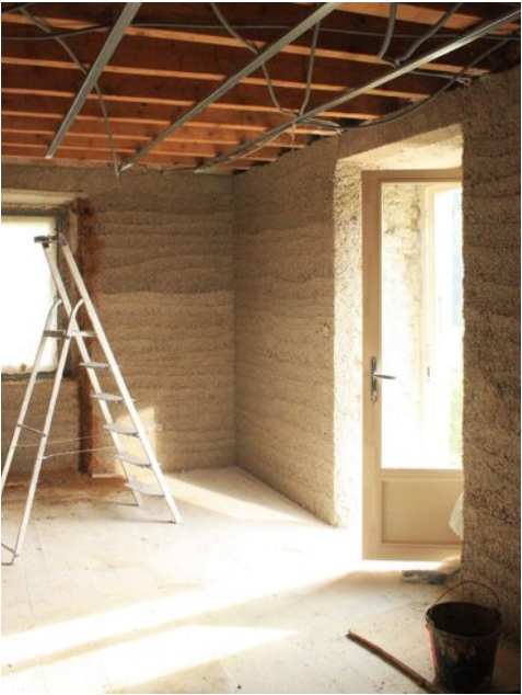
Transformation et rénovation d'un corps de ferme en habitat groupé, Saint-Martin-en-Vercors (26), 2026. Mesure Architecture, architectes associés. © Laura Roudeix
