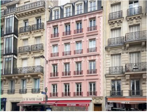
5 rue Lagrange, Paris 5 e — réhabilitation pour Habitat Social Français. © UVW
