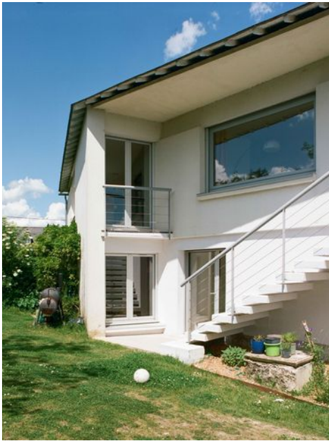
Maison Loire, Fondettes (37) — transformation d'une maison de béton des années 1960. © Samy Brillaud, en collaboration avec CRUE
