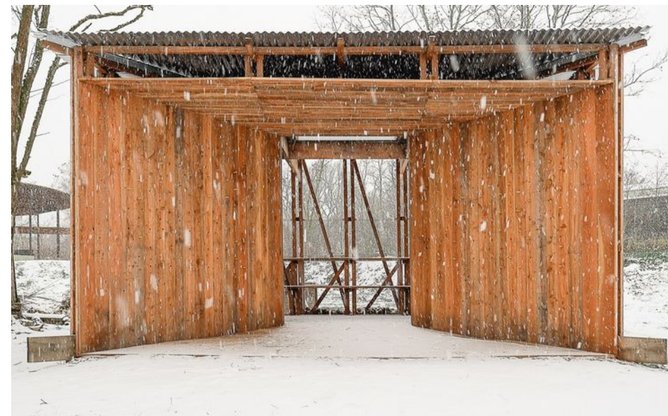
Auto-construction d'un pavillon à l'écomusée d'Alsace (68). © David Leininger
