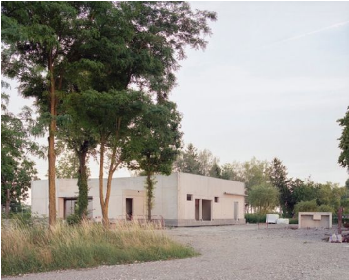
Carpes et Brochets, Mackenheim (67), 2026 — construction d'un club-house de pêche et salle polyvalente. Photo © Guillaume Porche, en collaboration avec 2G2A
