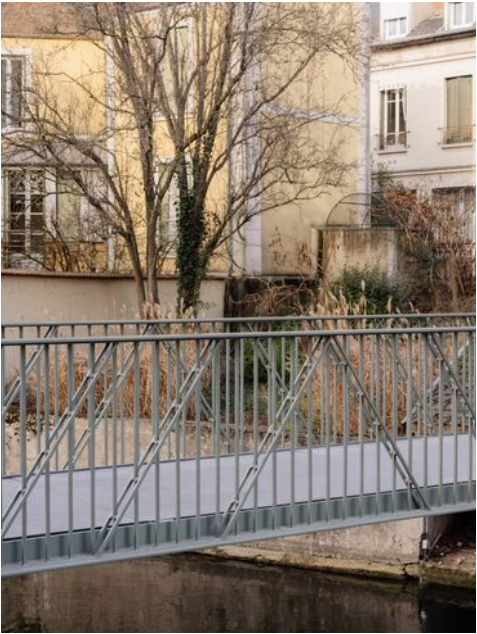
Passerelle Crété, Corbeil-Essonnes. © François Baudry
