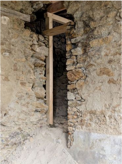
L'ancienne école, Ariège — rénovation en maison individuelle, chantier en cours. © James Kirk / KIRK Architecture
