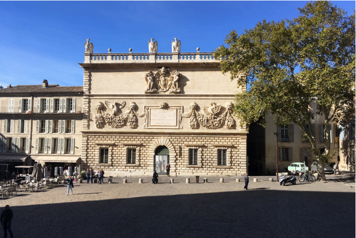
Hôtels Niel et des Monnaies, Avignon (84) — avec RL&A Architectes (mandataire), restauration et reconversion en établissement hôtelier 4 étoiles de 40 chambres, bar et spa. © Thibaut de Rohan
