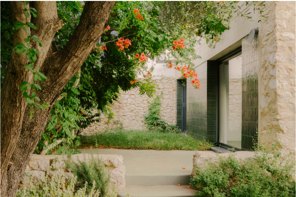
Extension d'une maison et réhabilitation de sa remise arrière, Marseille (13). © Maxime Verret
