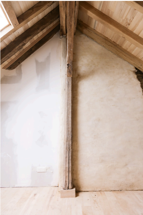
Enduit chaux, sable et bouse de vache. © Mathilde Cornu
