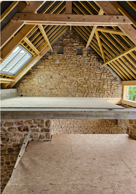
« Pature » — aménagement d'une maison dans une écurie et un garage agricole, Saint-Michel-des-Loups (50)
