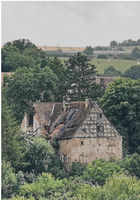
Restructuration lourde d’une ferme alsacienne dans le cadre du dispositif «Un archi pour mon gîte», en partenariat avec le Parc des Vosges du Nord, Obergailbach (57)
