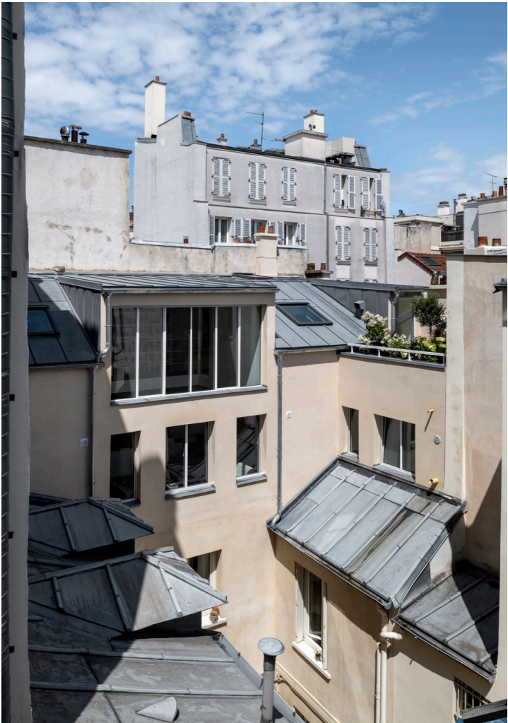
Surélévation faubourg Saint-Antoine, Paris (75), avec ACA architecte. © Ginevra Formentini
