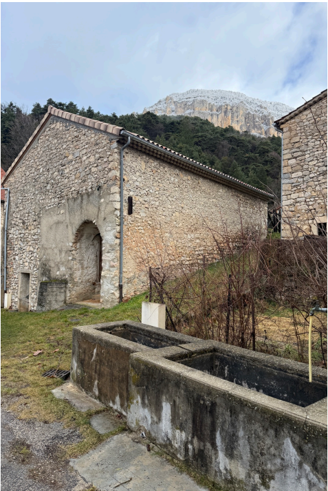
Réhabilitation de trois bâtiments communaux en logements et gîte d'étape, Châtillon-en-Diois (26)
