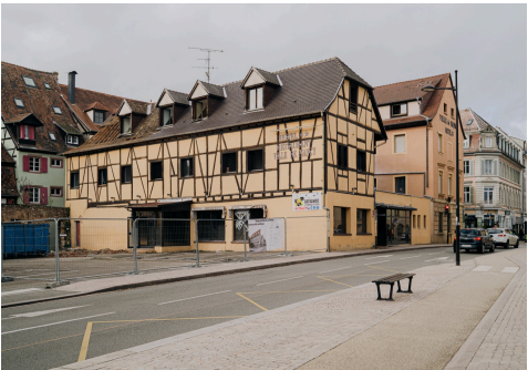
VDN — reconstruction d’un hôtel dans le centre historique de Colmar (68). Photographie de chantier Jérémy Baumert
