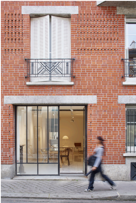
Locaux de RDTA studio dans un ancien garage du 10e arrondissement, Paris (75)
