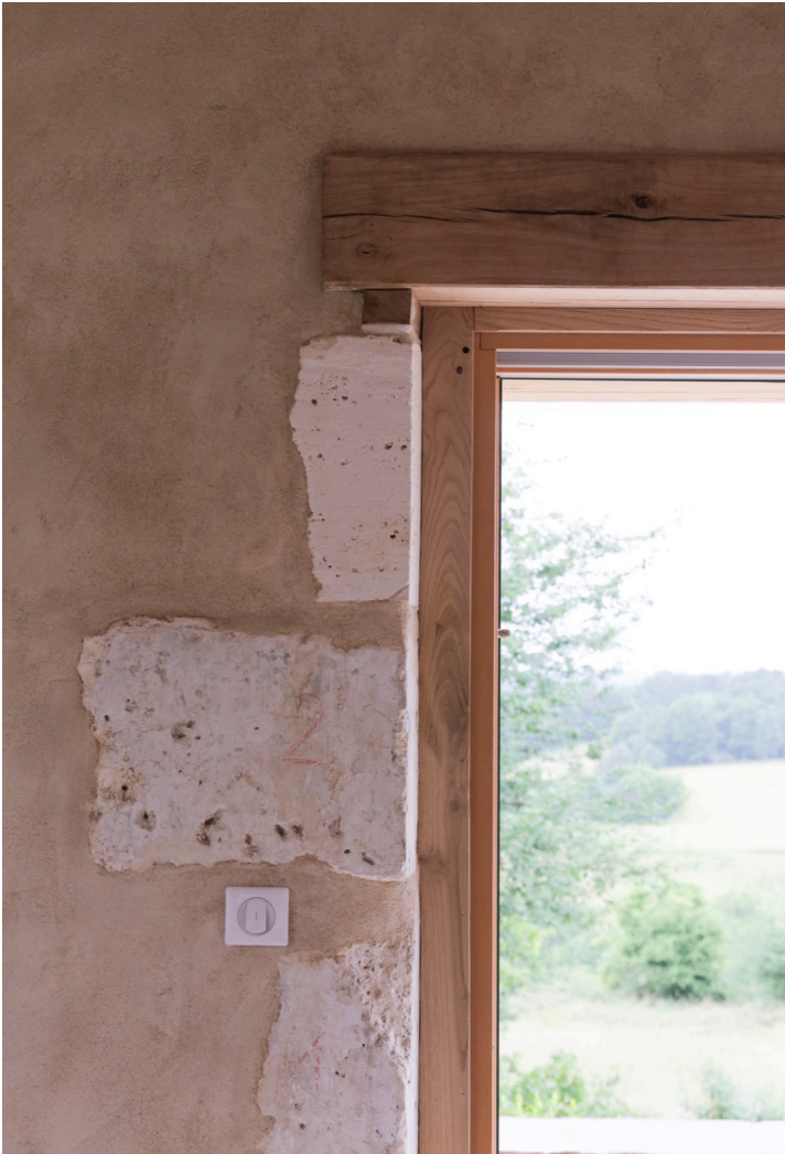
Création d'ouverture — chaînage d'angle en pierre. © Mathilde Cornu
