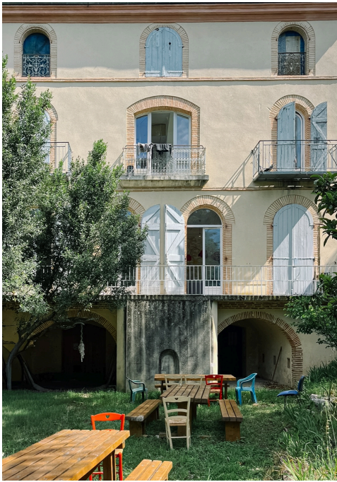
Le Relais de Montans — AMO pour les travaux d'humanisation d'un centre d'hébergement d'urgence et LHSS à Lisle-sur-Tarn (81), livré en 2025
