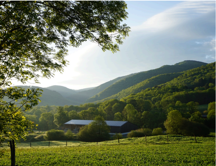
Construction d'une fromagerie, Albine (81)
