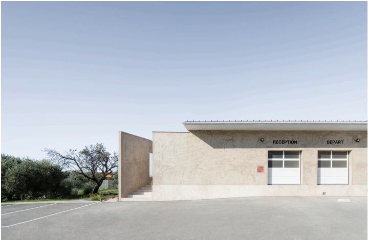
Réhabilitation et extension de la cuisine centrale de La Fare-les-Oliviers (13)
