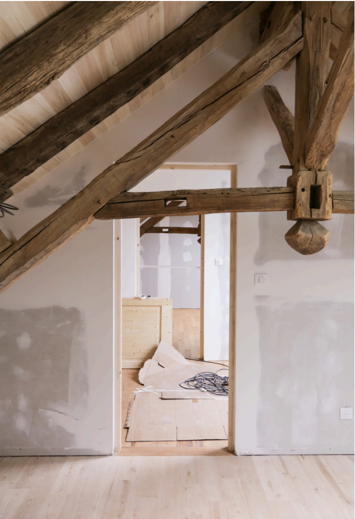
Aménagement des combles. © Mathilde Cornu
