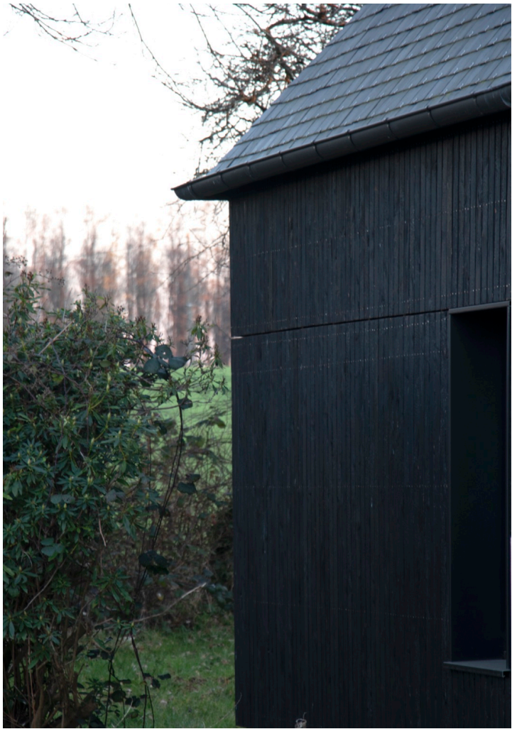
Restructuration et extension d’une longère à Edern (29). Photographie BALT
