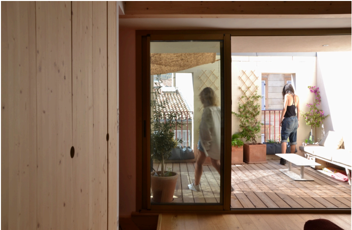
COD — surélévation avec création d’une terrasse à la marseillaise, Marseille (13). © Tout Va Bien
