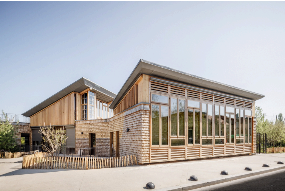
Maison de la biodiversité à Épinay-sur-Seine (93) — bâtiment zéro, en partenariat avec Frédéric Denise (mandataire), en matériaux locaux, bio et géosourcés et de réemploi. © 11h45
