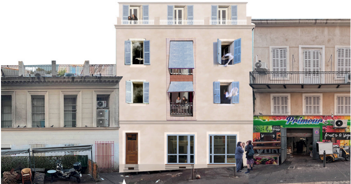
MUS — réhabilitation complète de deux immeubles, Marseille (13)
