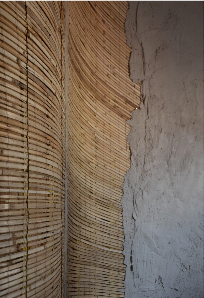
NDA — rénovation d’appartement avec création d’une cloison courbe en canisse et plâtre, Marseille (13). © Florentin Godeau
