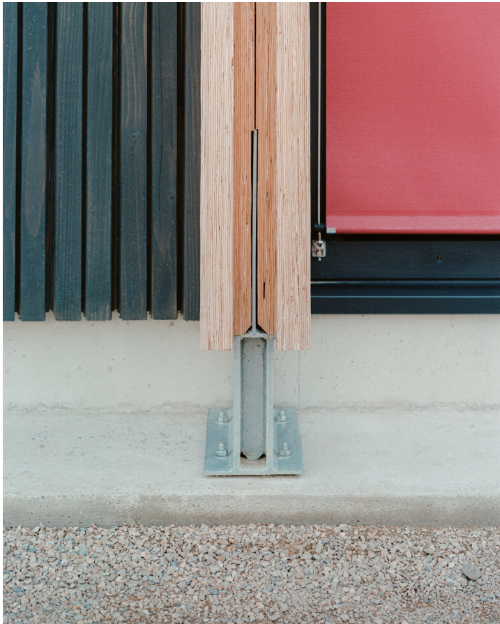
Projet de bureaux à Brive-la-Gaillarde (19), 420 K€ HT, MOA: professionnel, ©Charles Bouchaïb
