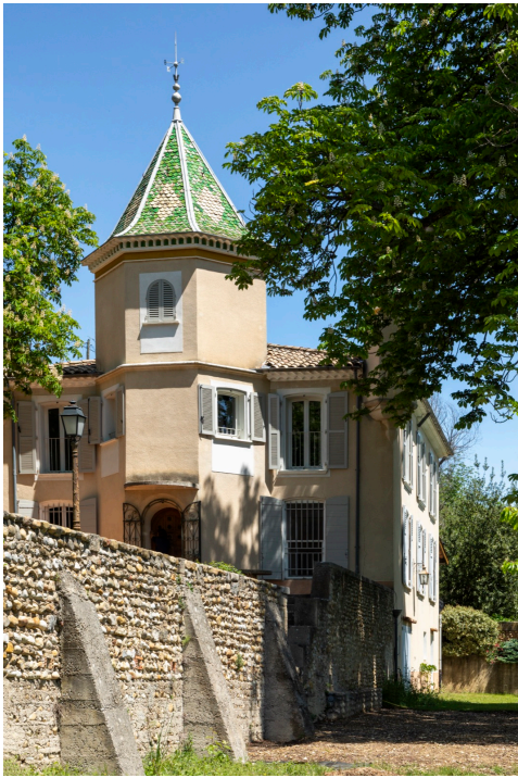
Rénovation d'une maison de maître à Valensole dénaturé par des rénovations successives. Agrandissement des ouvertures au 1 er niveau, remplacement des fenêtres en PVC par du bois, réfection des encadrements
