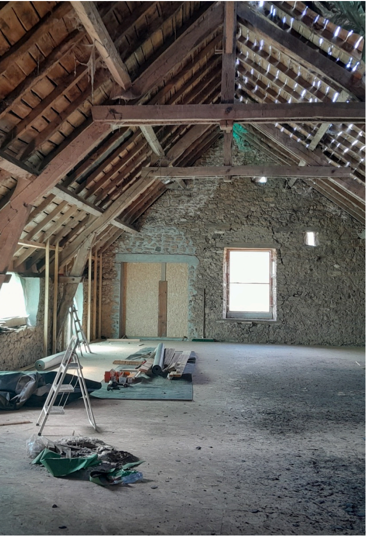
Bretagnolle, commune de Pierrefitte (19), Réhabilitation d'une longère corrézienne en habitation + espace d'entraînement circassien, projet privé, chantier en cours
