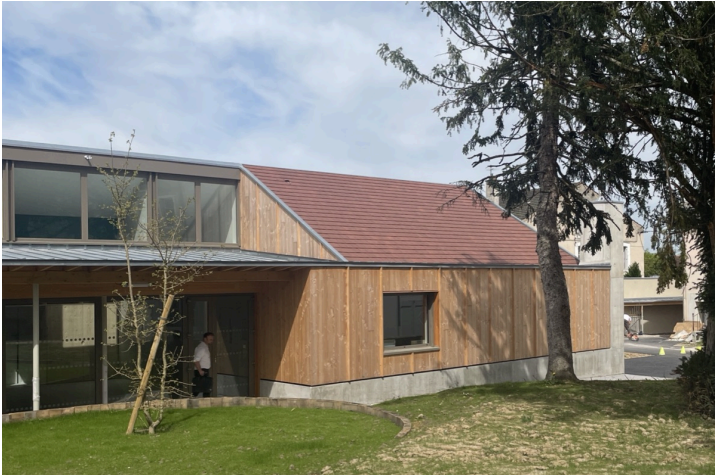
Construction d’un restaurant scolaire, Demigny (71), en cours de livraison, MOA publique
