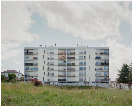
Photographie de l'existant de la résidence GANET à Brive-la-Gaillarde (19), 870 K€ HT, Projet de réhabilitation, MOA: Brive Habitat, ©Charles Bouchaïb
