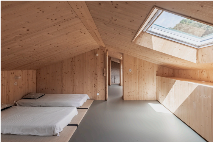
Réhabilitation d’un comble, Igé (71), livré (2021), MOA Privée
