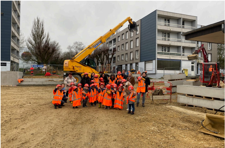
Visite de chantier de la place de la commune au Bourne avec les enfants de l'école Marcel Pagnol (53) #villeàhauteurdenfants #chantier #placepublique
