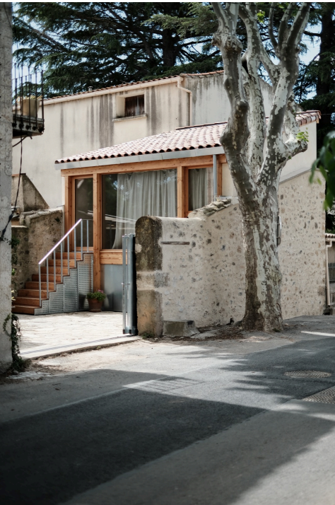
Usclas (34) Construction d'une annexe, structure bois – isolation chaux chanvre
