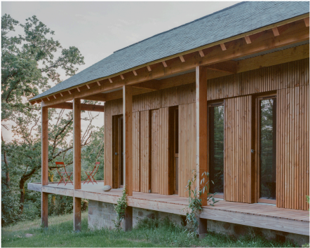
Extension et réhabilitation des existants à Saint-Céré (46), 450 K€ HT, MOA: particulier, ©Charles Bouchaïb
