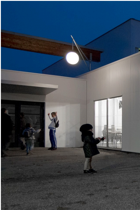
Construction d'un club-house adossé à un gymnase à Hoenheim – 67
