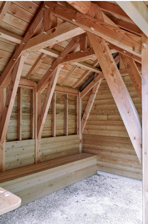
Commune de Lacelle (19), projet public, extension d'une bascule, création d'un préau et de sanitaires publics, détail de la charpente projet réceptionné en février 2023
