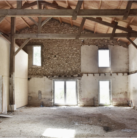
Vue sur l'extension intérieure depuis l'espace évolutif. Seule la boîte accueillant l'habitation est isolée thermiquement. L'espace de la grange est simplement clos et couvert, il n'est ni chauffé ni isolé. Les usages qui y prendront place fluctueront au fil des saisons. Photo de chantier.
