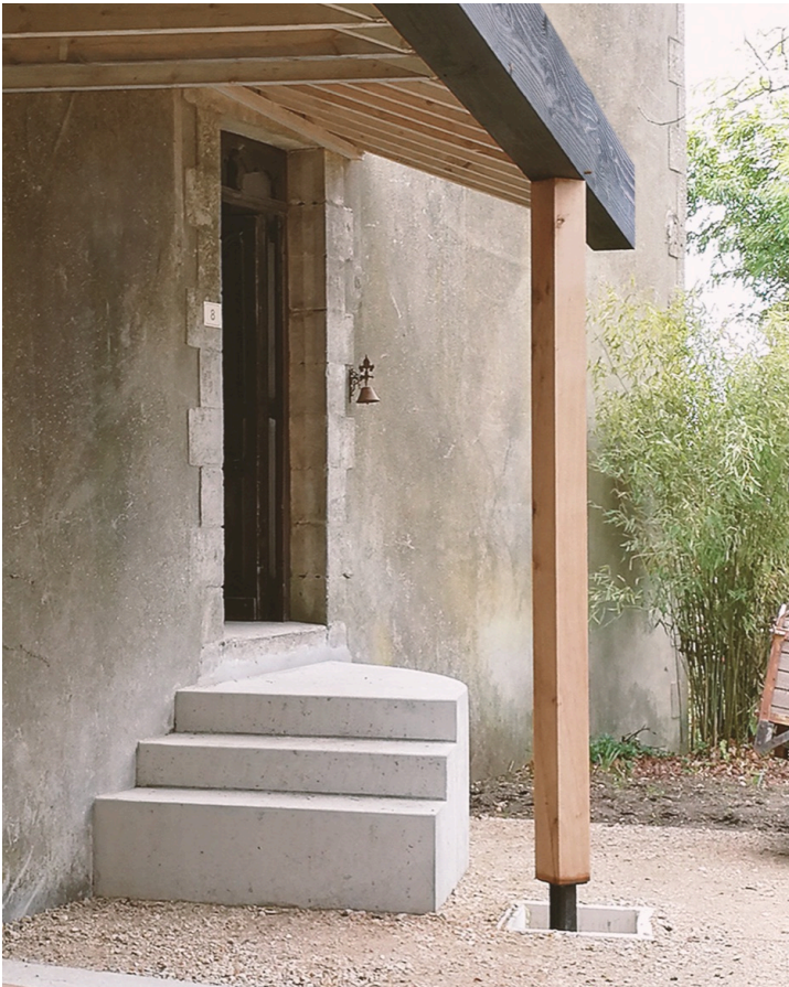
Ourtiguet – Transformation d'une grange en habitation et extension en ossature bois à Salles-Curan (12)
