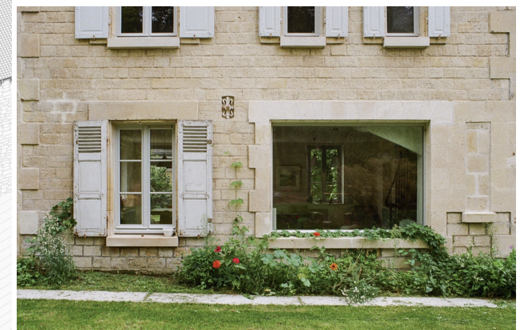
Rénovation lourde d'une longère à l'abandon - la façade, MOA privée, Aisne (02), livré 2022 @Camillacardia
