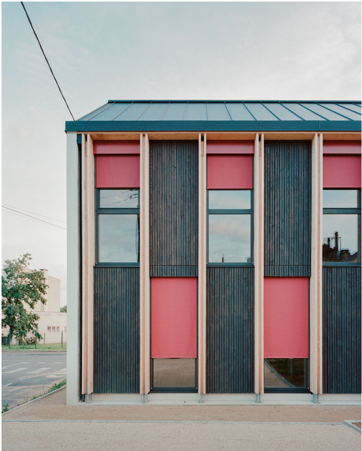
Projet de bureaux à Brive-la-Gaillarde (19), 420 K€ HT, MOA: professionnel, ©Charles Bouchaïb, MOA: professionnel, ©Charles Bouchaïb
