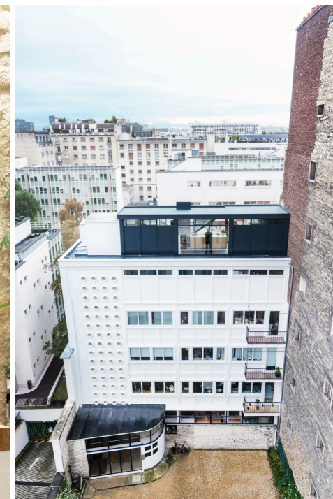
Surélévation d'un immeuble de logements des années 1950 à Paris (75)
