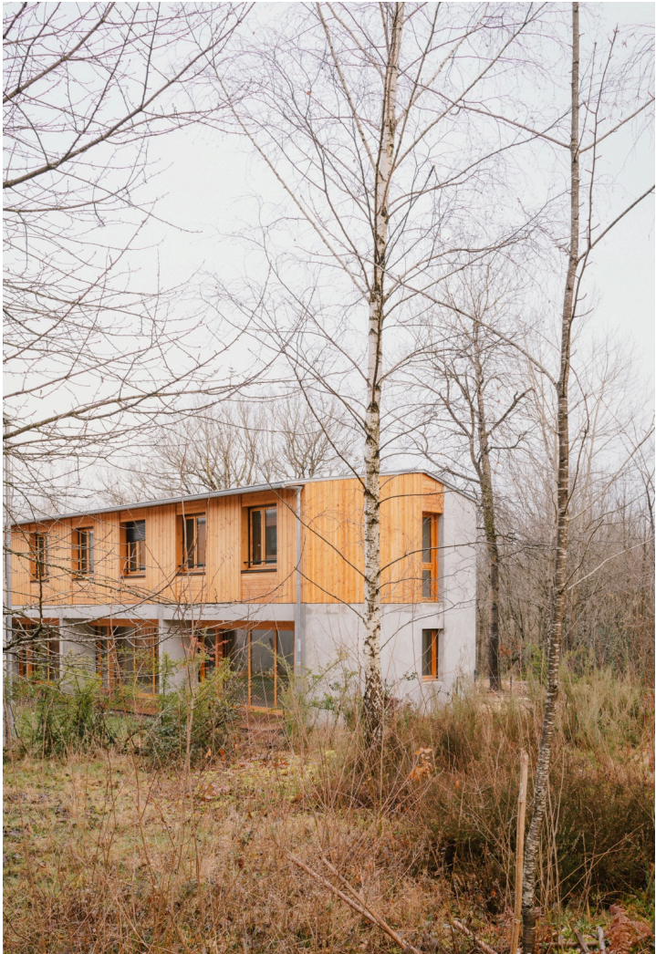
Construction d’un village SOSVE - Fontcouverte (17)
