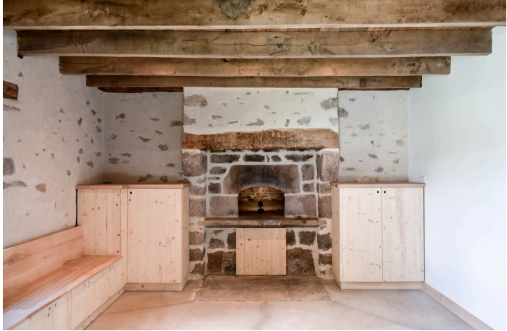
Projet au sein des locaux du Parc Naturel Régional du Plateau de Millevaches (19), projet public, réhabilitation d'un fournil en espace multimédia, projet réceptionné en juin 2023
