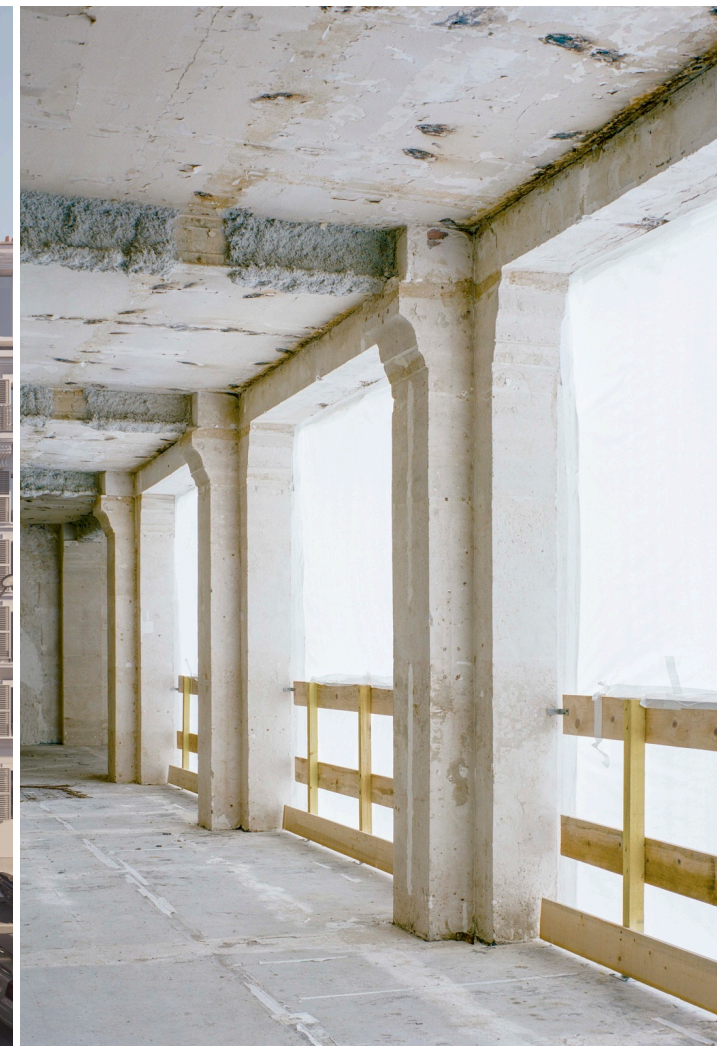
Restructuration d'anciens ateliers de confection de tissus en bureaux à Paris (75)
