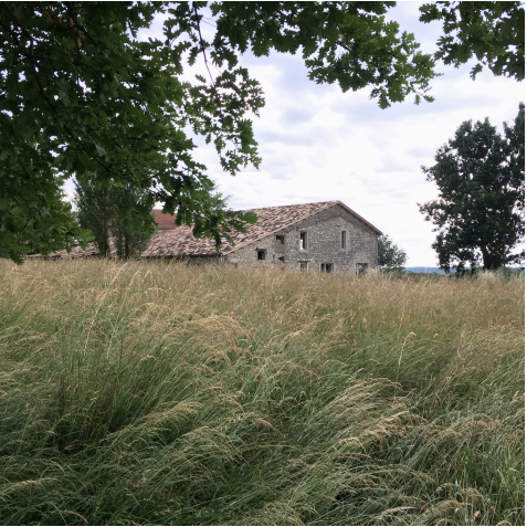
Réhabilitation et transformation d'un corps de ferme en habitation et espace évolutif, à Eymet (24). Vue avant travaux.
