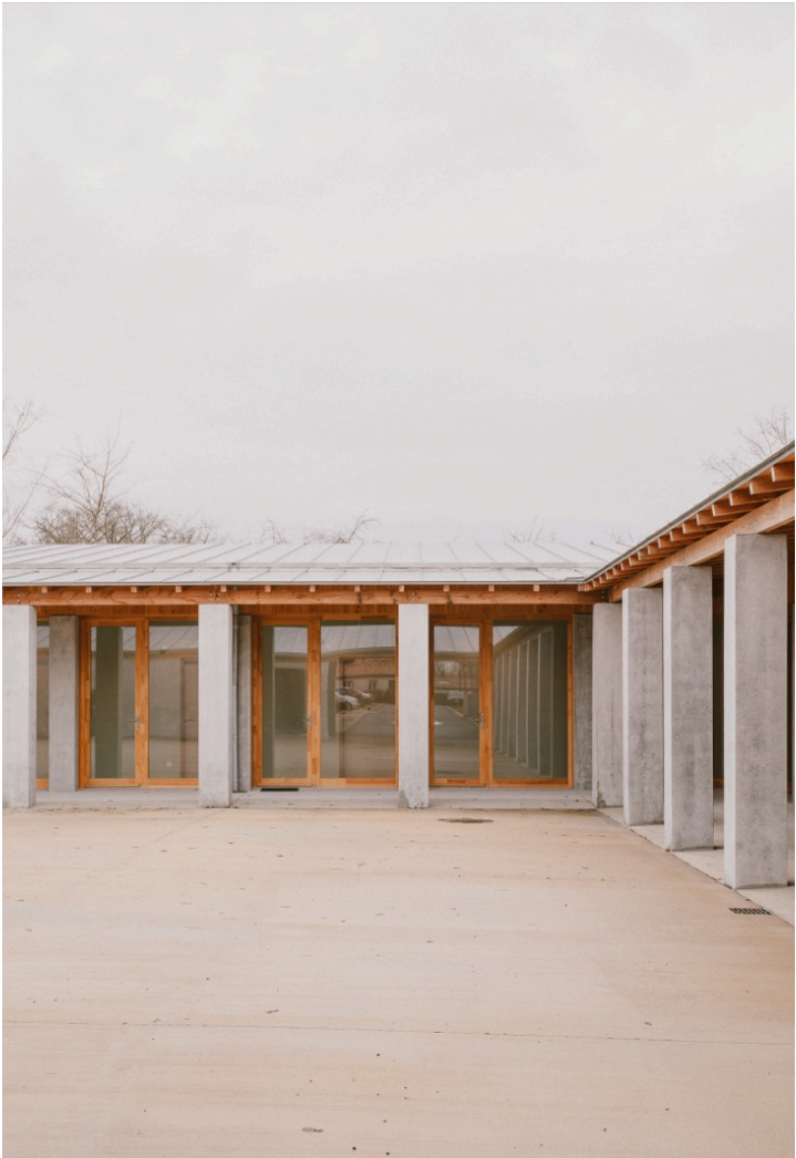
Construction d’un village SOSVE - Fontcouverte (17)
