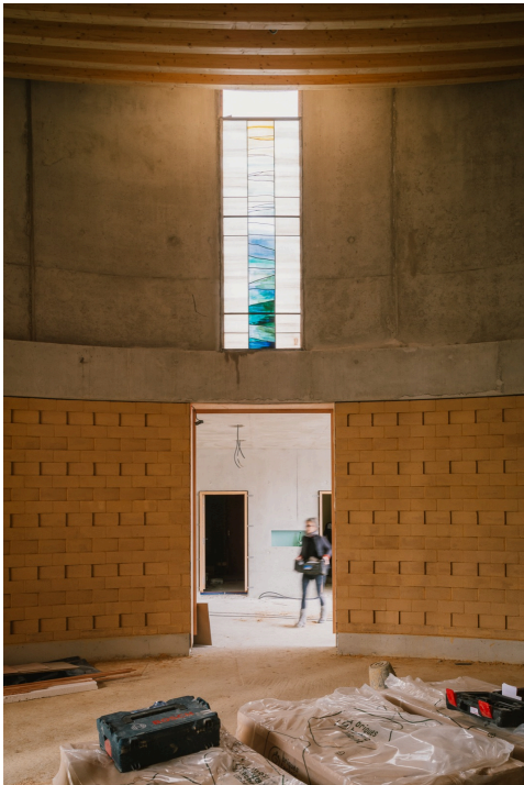
Construction de l’église Saint-Sauveur Toulouse (31)
