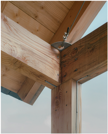
Extension et réhabilitation des existants à Saint-Céré (46), 450 K€ HT, MOA: particulier, ©Charles Bouchaïb
