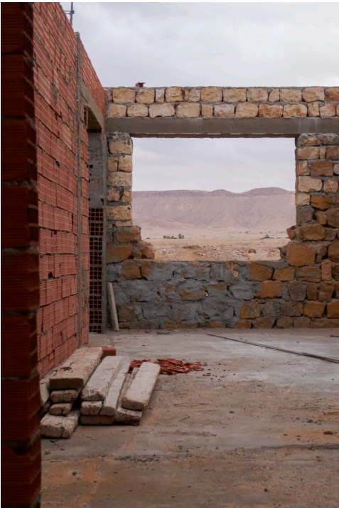
Construction d'une maison dans le désert, Tataouine, Tunisie
