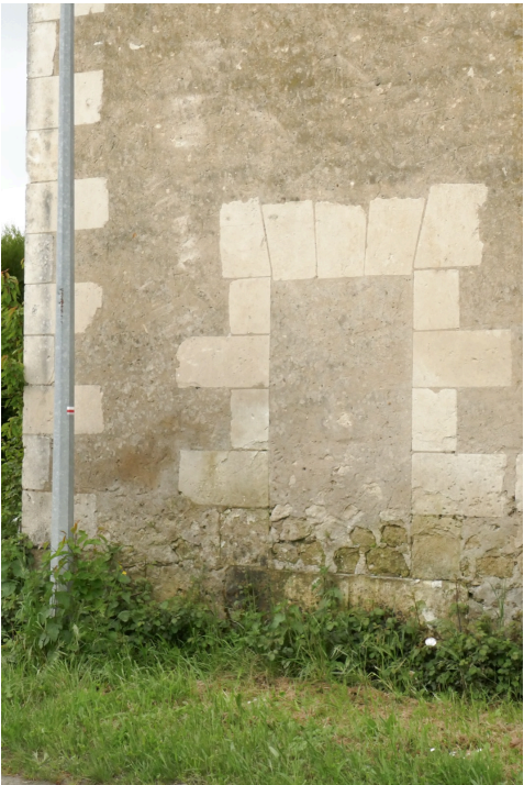
Réhabilitation d'une grange en ateliers et bureaux dans la Sarthe (72)
