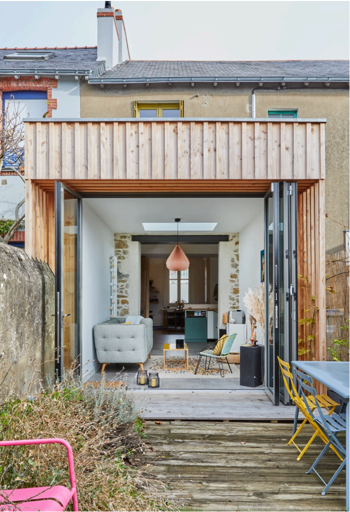
Extension / rénovation d'une maison de ville, Nantes (44) - MOA privée
