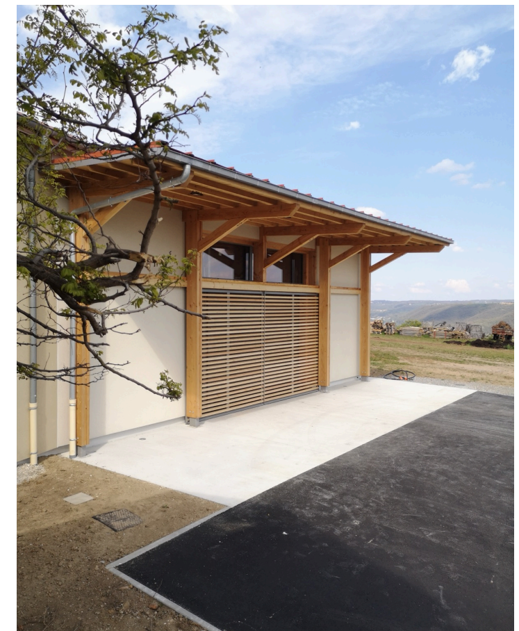
Construction d'un bâtiment de stockage vinicole à Condrieu (69)
