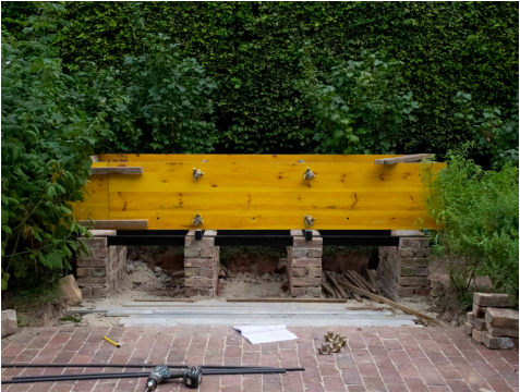
Cuisine d'été, Normandie, 2022, chantier en cours. © Alphée Grand
