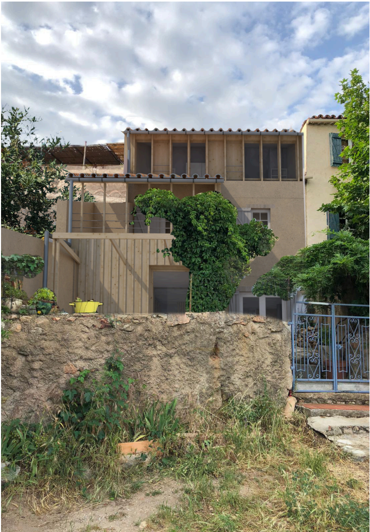
Maison L. au Plan de la Tour (83) — Extension et surélévation. © MOMESU
