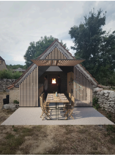
Transformation d'un four à pain en cuisine d'été et stockage modulable, Lot (46)
