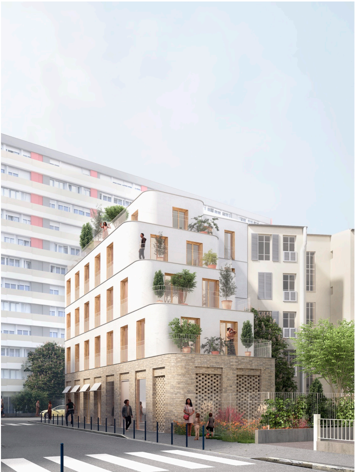
Création de 7 logements collectifs et 1 commerce, Pantin, France, 2022-2023. © Studio Albédo et MaO architectes
