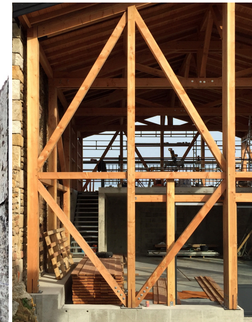
Construction d'un bâtiment agricole à Chavanay (42)
