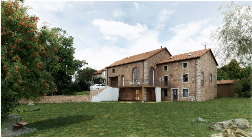
Réhabilitation d'une grange étable en habitation, Livradois-Forez, 2022. © Atelier DL
