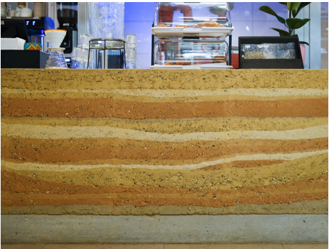
Aménagement d’un coffee-shop en gare de Paris Austerlitz — Photo du comptoir en terre pisé réalisé par Amâco artisan terre (photo Ivan Mata), 2022. © Seconde ligne & Lucas Huvet architecte
