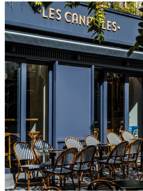
Les Canailles — Réhabilitation d'un bar à vin, Clermont-Ferrand (63). Maîtrise d'ouvrage privée. © Hugo Mallat, studio Vibrances
