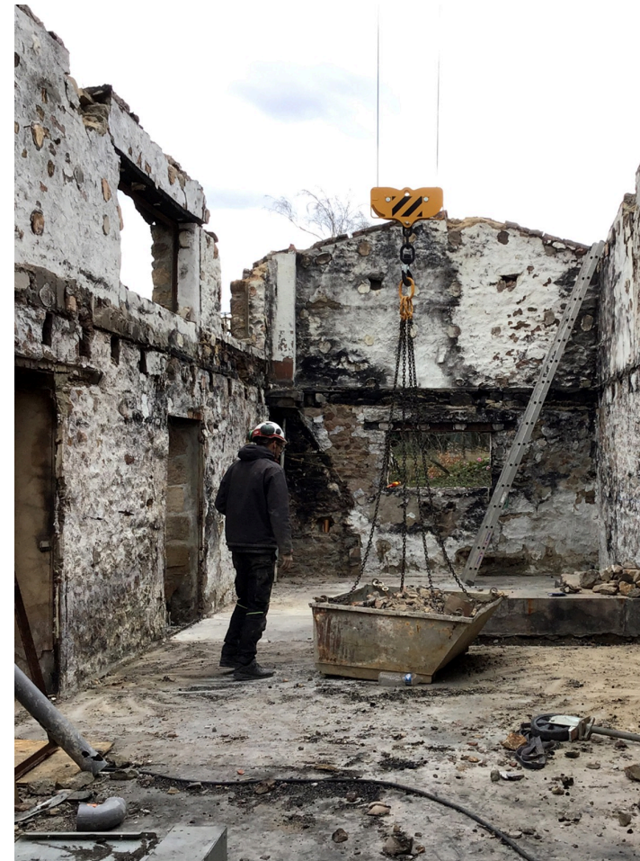
Tinal — Reconstruction d'une maison après un incendie à Vérin (42)
