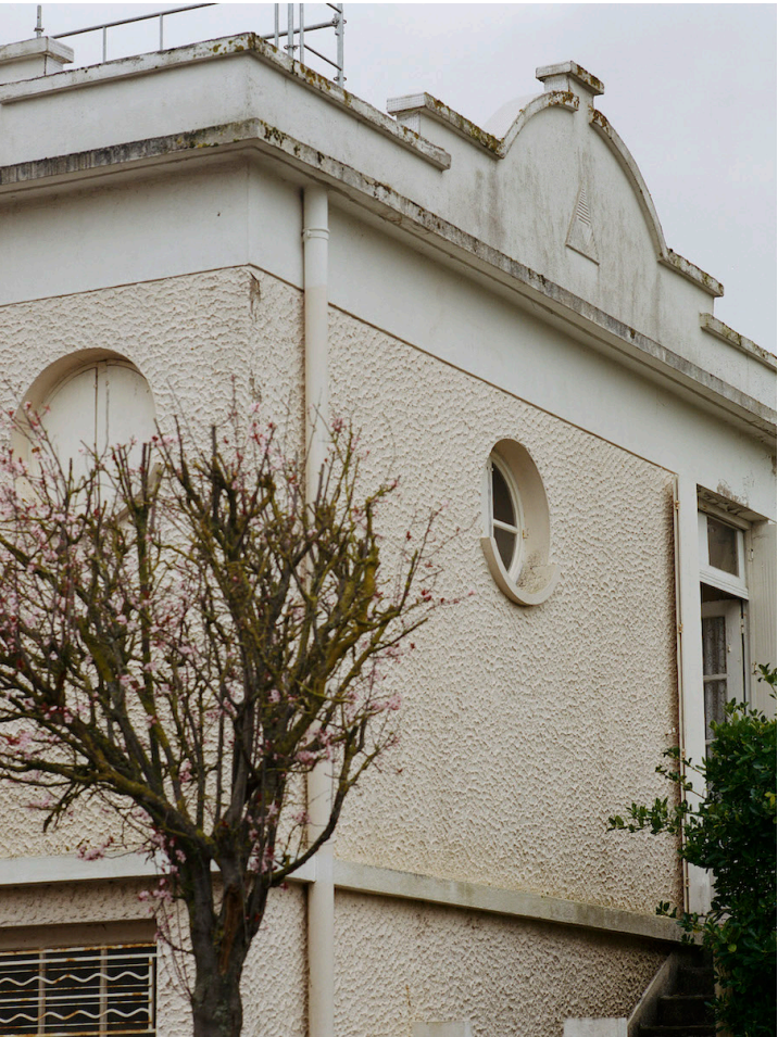
Relevé et état des lieux pour une réhabilitation et extension de maison de plage à Ouistreham. Il s'agit d'une maison d'entre deux guerres dont la façade et le toit-terrasse sont en rupture avec le tissu néo-balnéaire à « pan de bois » qui l'entoure. Cette petite construction semble s'inscrire dans un corpus de maisons balnéaires du début du XXe siècle. © Antoine Omerin
